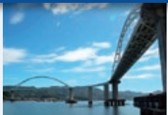
下から見上げる内海大橋
